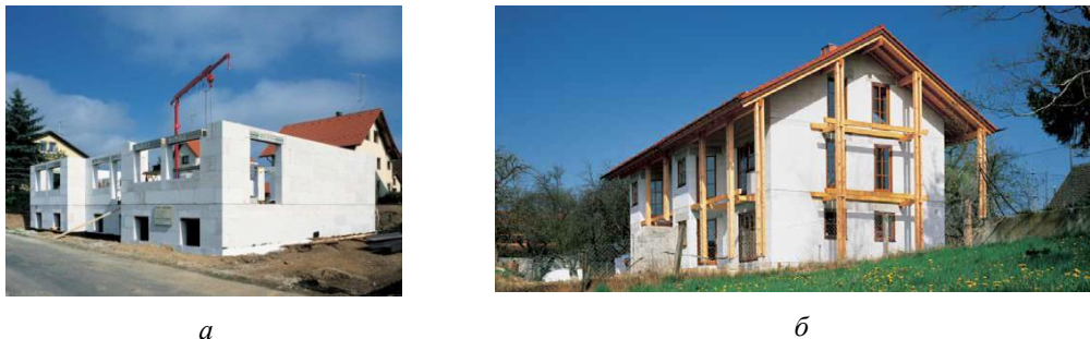
Рис. 1. Коттеджи из газобетона YTONG: а — кладка стен; б — финишная отделка
