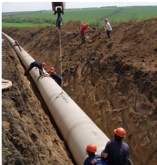
Рис. 3. Открытая прокладка стеклопластиковой трубы большого диаметра
