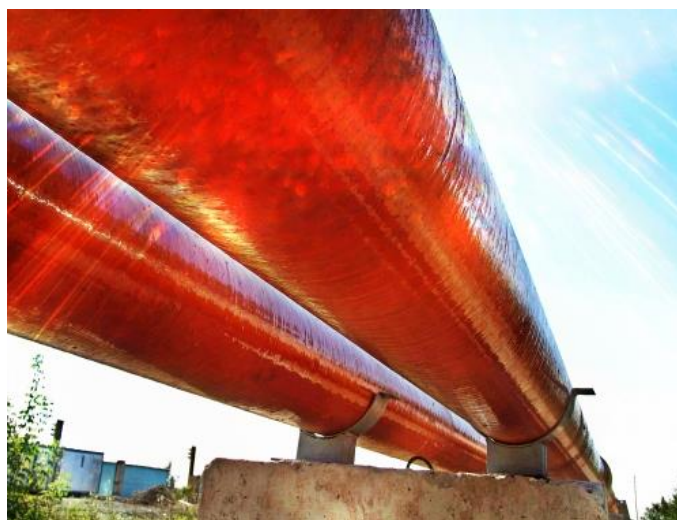
Рис. 2. Стеклопластиковые трубы, проложенные на опорах
