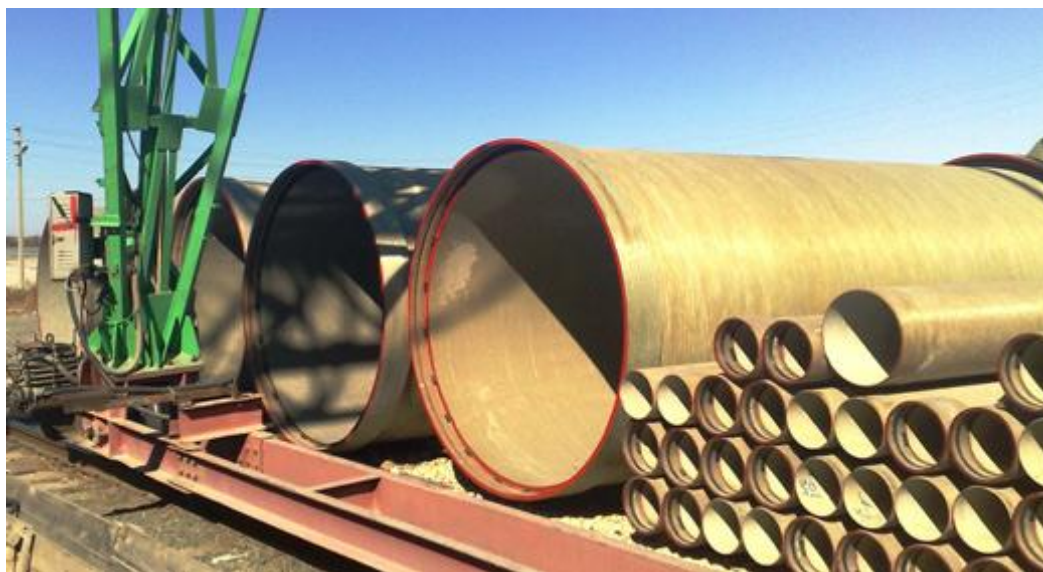
Рис. 4. Перемещение стеклопластиковых труб с железнодорожного состава
