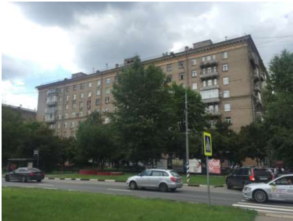
Рис. 1. Общий вид здания
