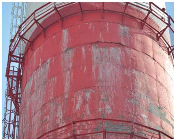
Рис. 4. Процесс выщелачивания свободной извести по ослабленным сечениям бетона
