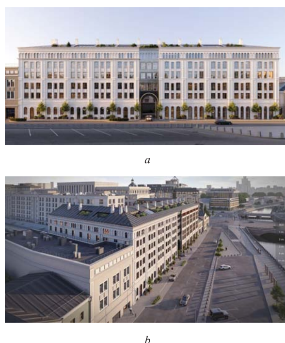
Рис. 4. Клубный дом «DUO» на Софийской набережной, г. Москва 4 : a — фасад; b — вид с высоты птичьего полета
