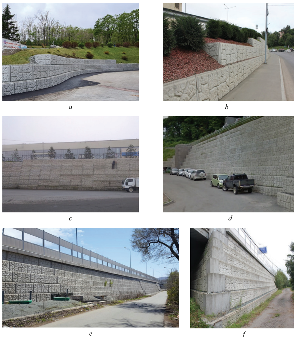
Рис. 3. Подпорные стены из заполненных щебнем блоков: a — на территории Всероссийского детского центра «Океан» (Владивосток); b — в районе торгового центра «Калина Молл» (Владивосток); c — на ул. Командорской (Владивосток); d — в районе жилого микрорайона «Снеговая падь» (Владивосток); e, f — на трассе Де-Фриз – Патрокл (Владивосток)
