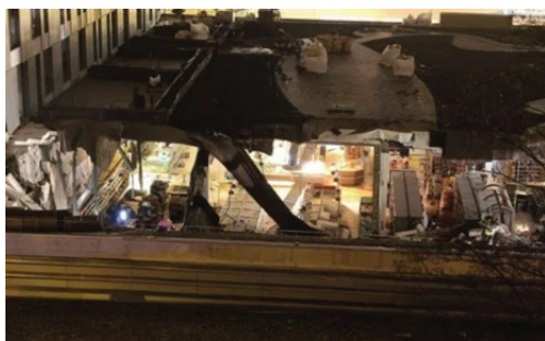
Рис. 4. Обрушение торгового центра «Maksima», г. Рига, 21.11.2013 4
