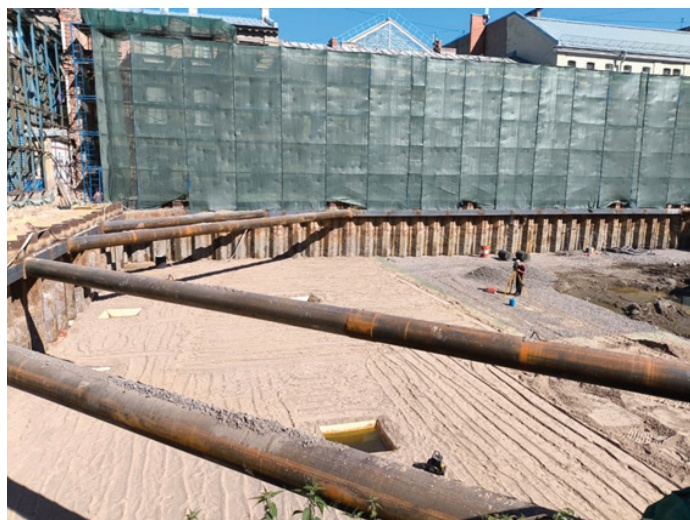
Рис. 3. Фотография объекта строительства
