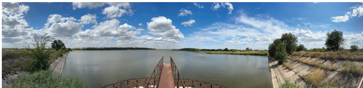
Рис. 1. Вид с верхового откоса плотины, шахтный водосброс Михайловского I водохранилища
