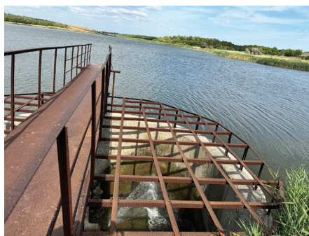
Рис. 8. Верховой откос плотины, шахтный водосброс
