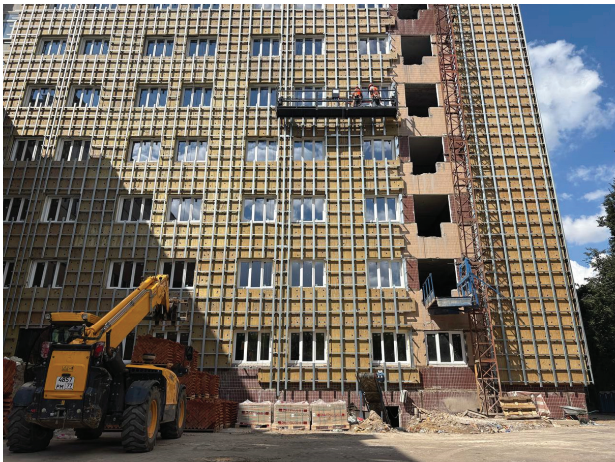
Рис. 3. Фрагмент фасада объекта, где проводятся работы по монтажу системы навесных фасадов
