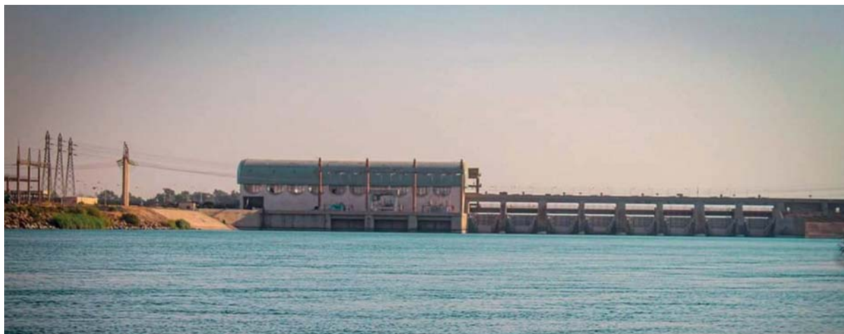
Рис. 3. Вид руслового напорного здания ГЭС Аль-Баас
