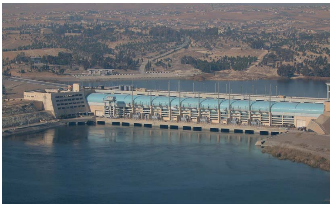
Рис. 1. Русловое здание ГЭС Тишрин
