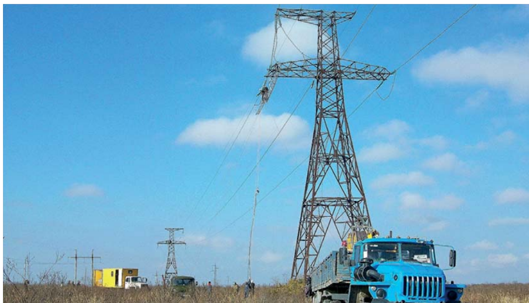
Рис. 3. Реконструкция ВЛ 220 кВ «Афипская – Крымская» с заменой старых проводов типа АСО-300 на высокотемпературные провода типа GTACSR 217/49 японской компании J-Power Systems с использованием современной технологии «монтаж под тяжестью» [12]
