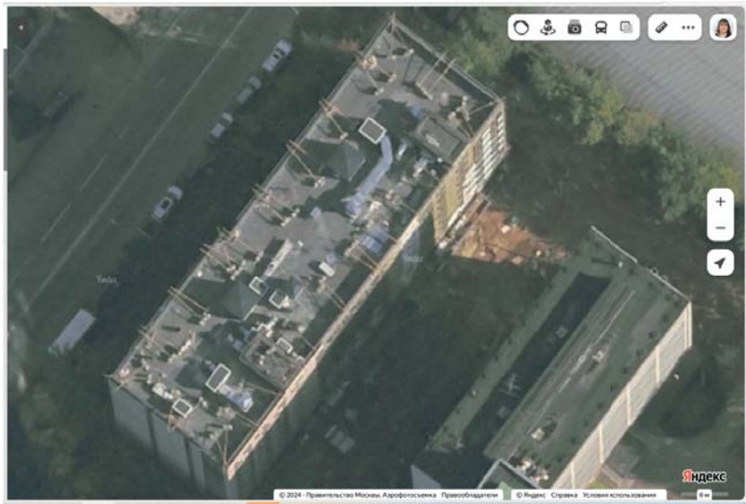
Рис. 8. Внутренняя и внешняя отделка, благоустройство территории
