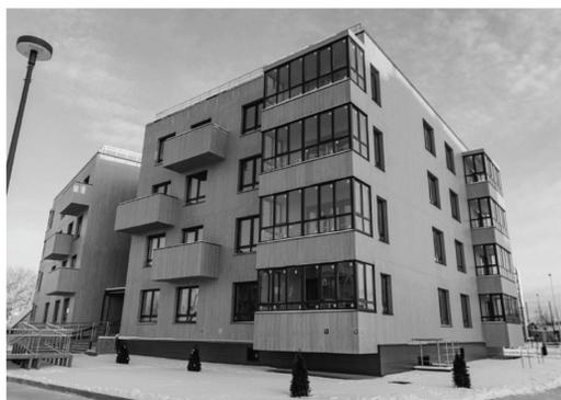
Рис. 1. Многоэтажные жилые здания из CLT-панелей в России
