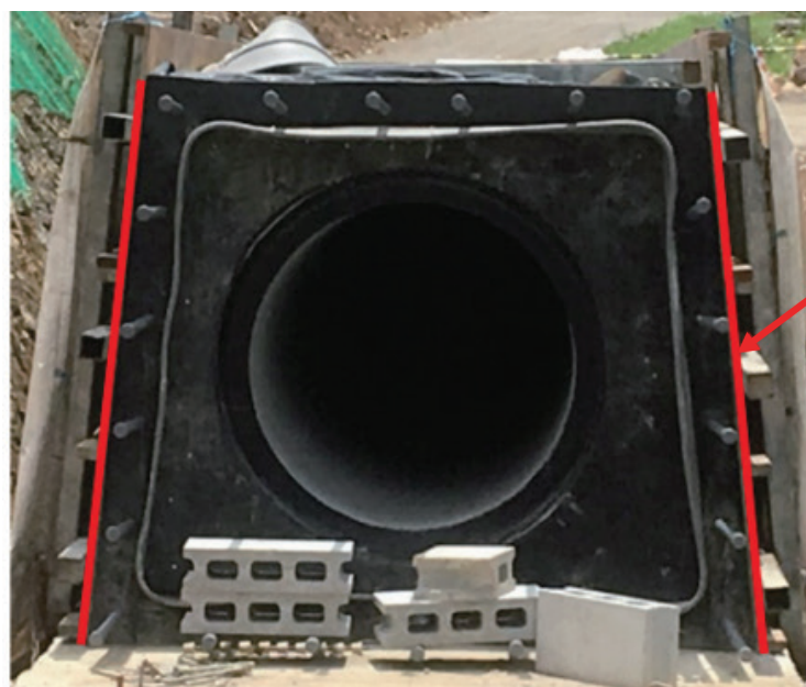
Рис. 6. Текущая общая форма водопропускной трубы грунтовой плотины в Японии с наклонными внешними стенками с уклоном 0,1
