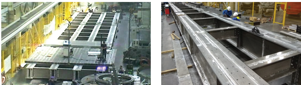
Рис. 16. Контрольная сборка элементов пролетного строения на заводе
