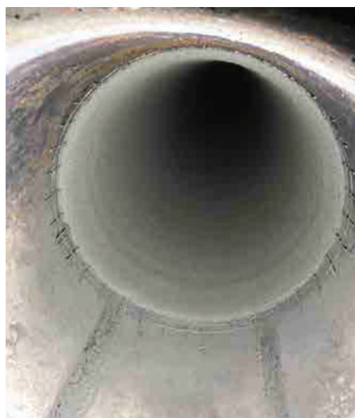
Рис. 2. Фрагмент нанесенного на обрешетку защитного покрытия по технологии «Арм-Пайп»
