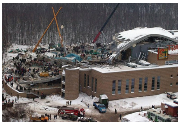
Рис. 1. Обрушение здания аквапарка «Трансвааль-парк», г. Москва, 14.02.2004 1
