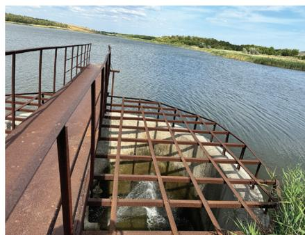
Рис. 8. Верховой откос плотины, шахтный водосброс
