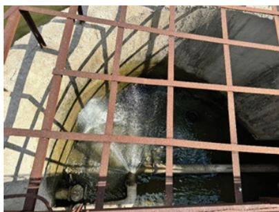
Рис. 7. Прорыв трубы шахтного водосброса на водохранилище Михайловское I
