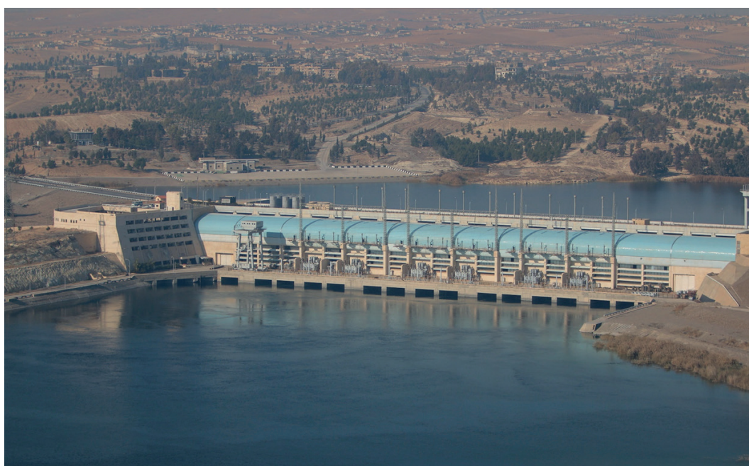
Рис. 1. Русловое здание ГЭС Тишрин
