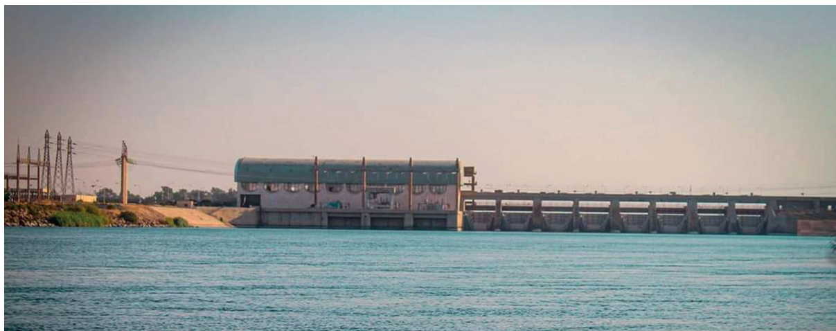
Рис. 3. Вид руслового напорного здания ГЭС Аль-Баас
