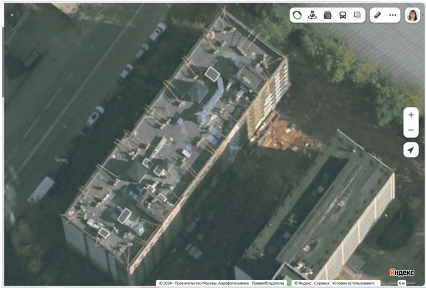
Рис. 8. Внутренняя и внешняя отделка, благоустройство территории
