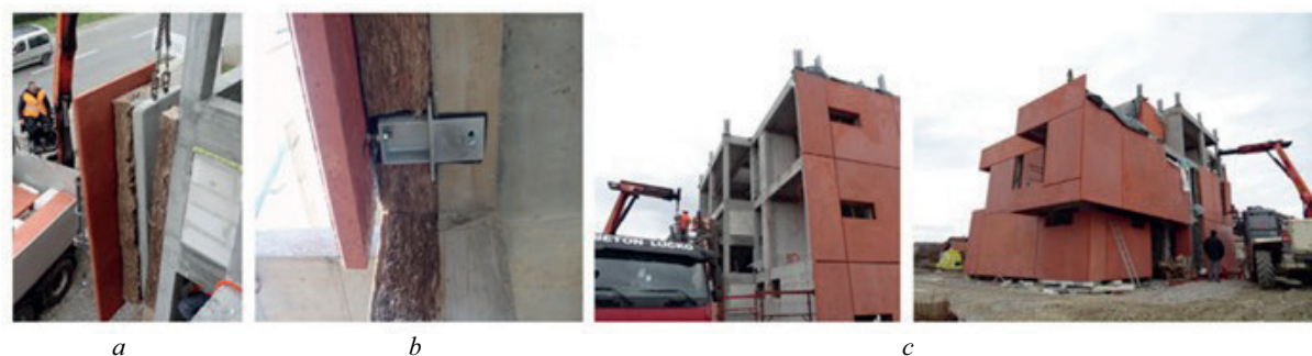
Рис. 1. Жилой дом, собранный из модульных фасадов, по данным М. Bagarić и соавт.: a — модульная стена; b — крепление модулей друг к другу; c — финальный этап сборки здания [8]
